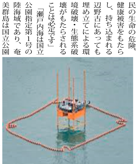
辺野古沖の海上に設置された、海底ボーリング調査で使用するスパット台船
