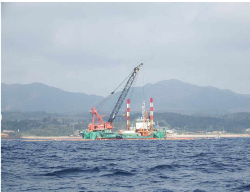
大浦湾で粛々と工事を進めるボーリング調査船
