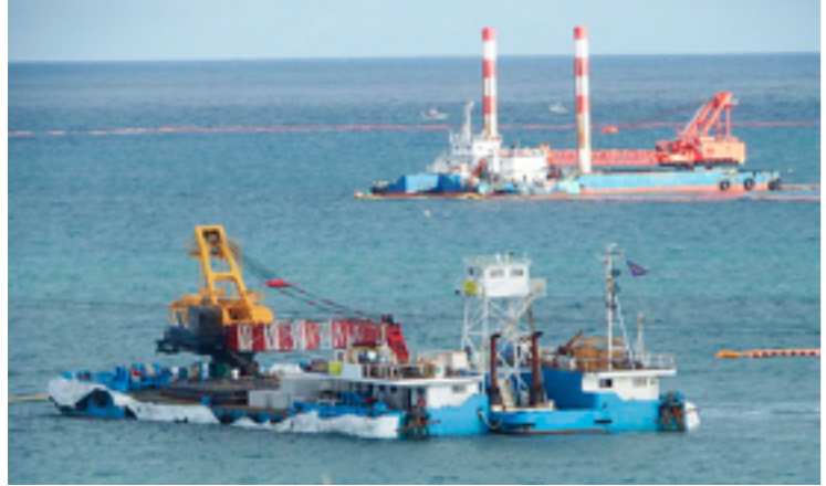
大浦湾で作業するクレーン船
