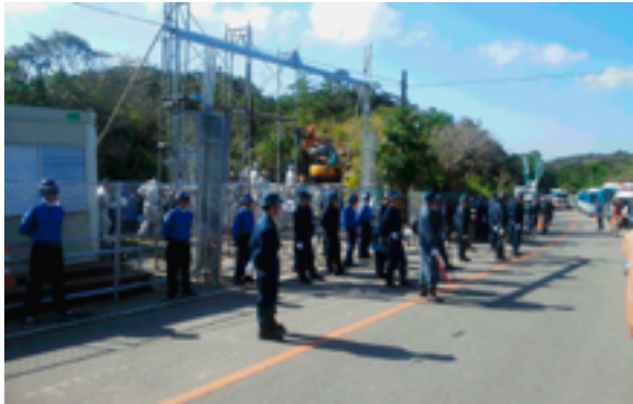
写真8 今は次々に10トンダンプがゲートに入り、工事道路が作られていく。
