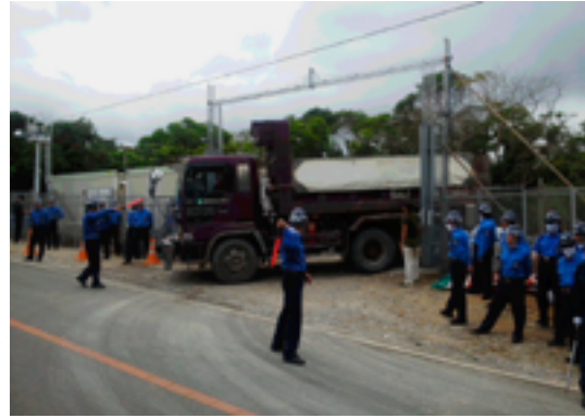
写真7 「高江住民の会」テントも阻止車両も撤去され無し。ゲート前入り口には、もう業者のための新ゲートが作られ、ゲート内ではコンボ等の工事車両が動いて、工事が着々と進んでいる。
