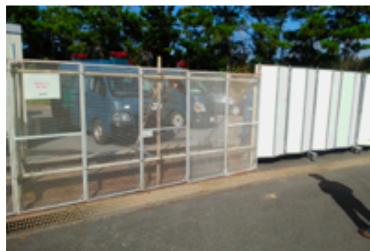
写真5 パッドGとHの入り口に新設されたゲート
