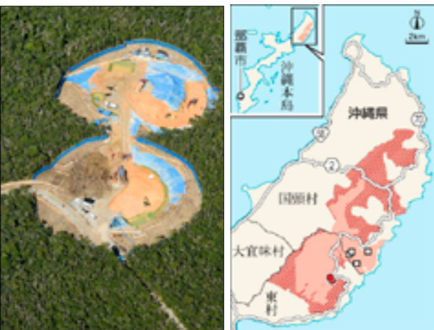
高江10上空から見たヘリパッド建設現場
