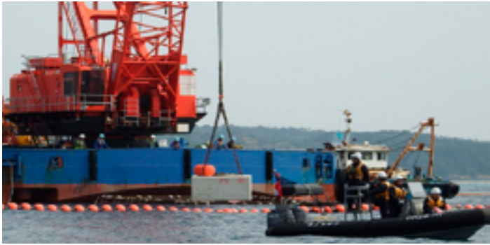
④「汚濁防止膜」を固定するための重り(ブロック)を海に投下する。
