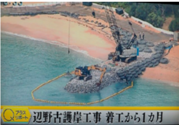
K9護岸工事の様子
