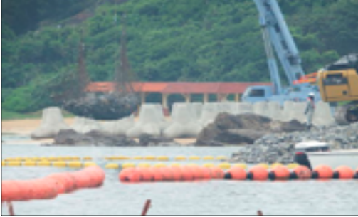
K9護岸工事の消波ブロック
