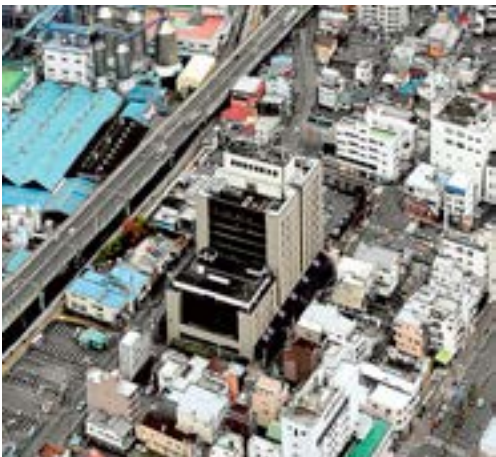
上空から見る静岡市清水区庁舎
