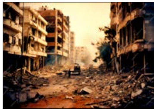
破壊されたガザ地区建物
