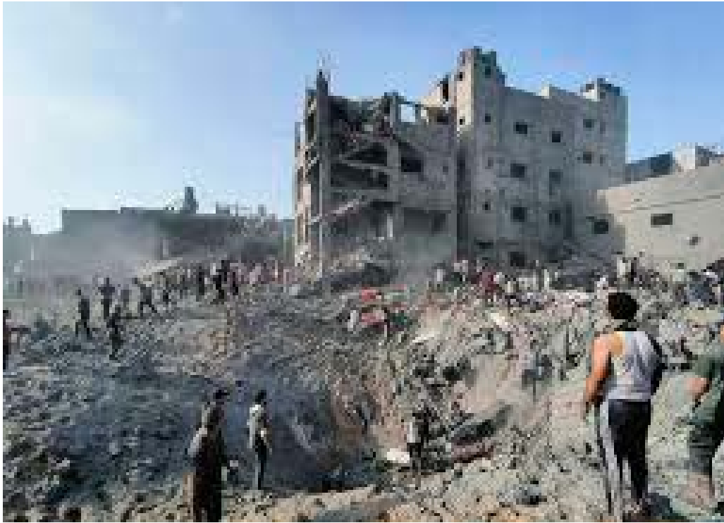
病院もインフラも壊された - イスラエル軍の空爆で破壊されたガザ北部ジャバリヤ難民キャンプのビル
