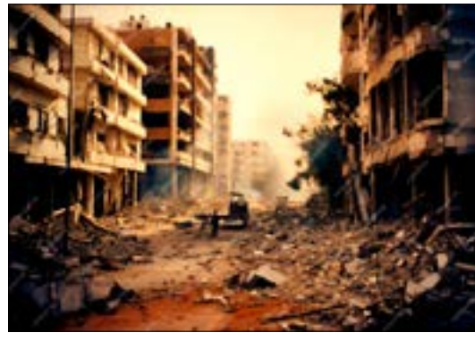
破壊されたガザ地区建物
